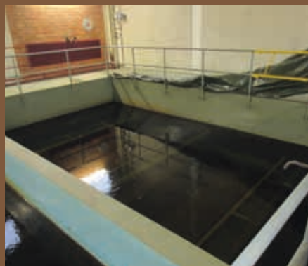
Avjärningsbassäng renoverad med polyurea.
